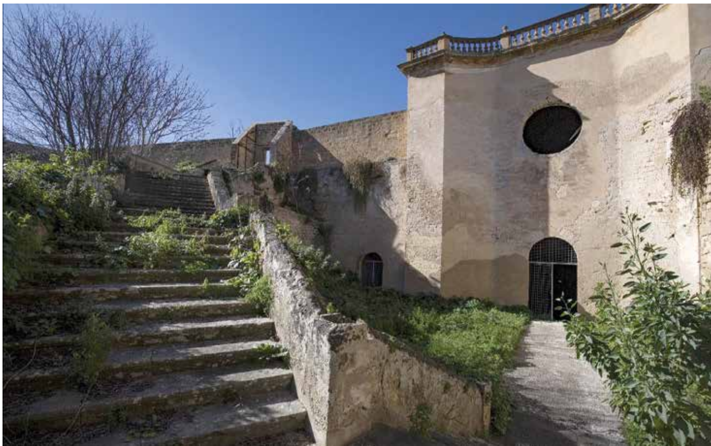
Fig. 2 – L'odierno accesso al complesso e la facciata della chiesa barocca
