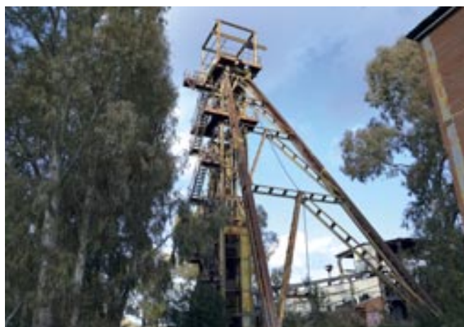
Caltanissetta, miniera Gessolungo, pozzo Tumminelli
