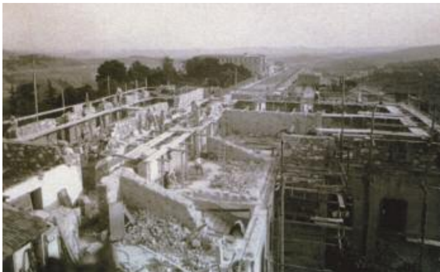
1935, lavori di completamento del 3° piano
